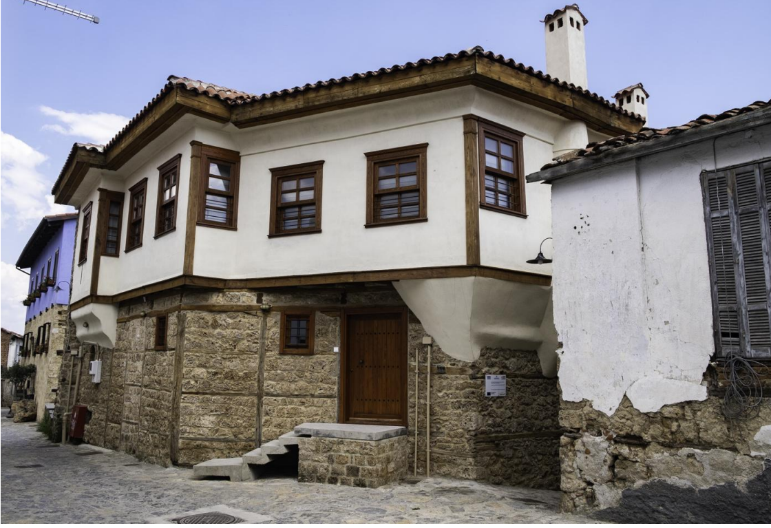
Edessa, Modernize edilmiş eski Osmanlı evlerinden biri.
